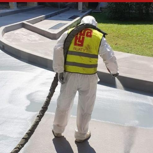
Syntech Poliurea Spray - FL es una poliurea pura estudiada para la aplicación específica en pavimentaciones de pasos de coches y estacionamientos en general. 100% sólida, no contiene VOC y puede aplicarse solo por rociado por medio de adecuadas máquinas bímix. Se caracteriza por un alto grado de alargamiento. Es un elastómero de revestimiento obtenido por la reacción de un isocianato de tipo aromático con una amina.
