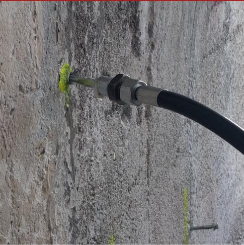
Elemento de conexión entre los inyectores de cabeza plana y el tubo de bombeo de bombas manuales o eléctricas, utilizado para bloquear las infiltraciones de agua mediante inyecciones de resinas de poliuretano hidrorreactivas.
