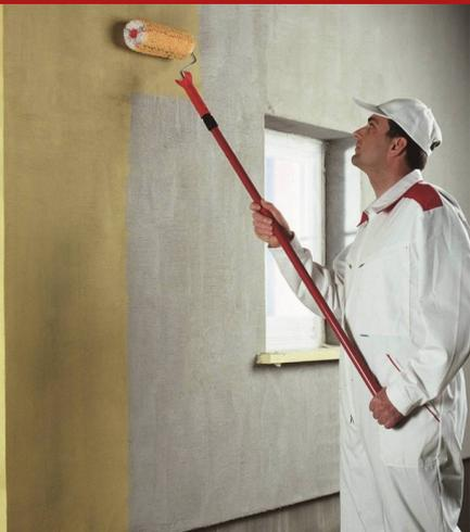
Pintura transpirante, natural, no toxica, para externos e internos, a adhesión y estructura microcristalina, a base de silicato de potasio estabilizado. Formulación a base mineral, activa, de altas capacidades antimoho naturales y anticondensación, preparada según las recetas de tradición, para su uso en intervenciones de la bioconstrucción, en las nuevas construcciones y reforma de edificios de época y monumentales.
