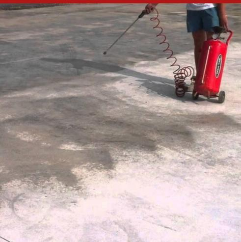
Endurecedor revitalizante químico-mecánico, antipolvo, para pavimentos y soleras de hormigón, constituido por una solución acuosa de silicatos y fluosilicatos minerales, activados por agentes humectantes especiales. Se aplica en varias manos, en dilución decreciente en agua, con brocha o "fregadora" mecánica. Específico para tratamientos antipolvo de pavimentos suelos industriales o soleras de hormigón que han perdido su "vitalidad" original.
