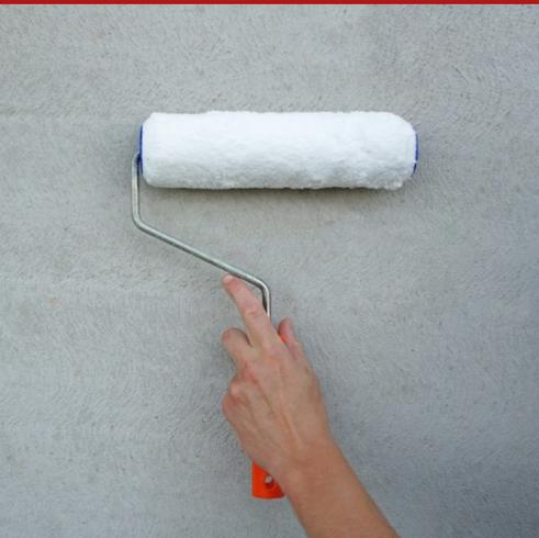
Primer, fijador consolidante, transparente, a base de resinas siloxánicas en medio agua, específico para el tratamiento previo de revocos antes de la aplicación de la pintura a los siloxanos Protech Sil P o del enlucido a los siloxanos Protech Sil I, en las intervenciones de saneamiento de edificios civiles e industriales y en las nuevas construcciones.
