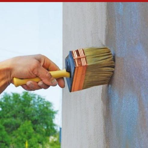
Fijador consolidante de alta penetración, no pelicular, a base de polímeros acrílicos ultra finos generados con promotores de adhesión hidrodispersionados. Adecuado como primer, fijador antipolvo, previo a la pintura o al recubrimiento de los revocos con pinturas o revocos acrílicos. Utilizado solo, es un excelente tratamiento antipolvo consolidante cortical de antiguos revocos inconsistentes.
