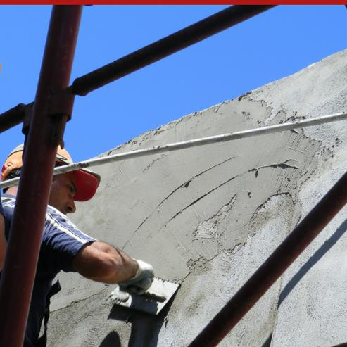
Impermeabilizante cementicio para la preparación, con la única adición del agua, de un revestimiento osmótico impermeabilizante capaz de realizar barreras horizontales y verticales, aptas también en condiciones de empuje hidrostático negativo respecto de las permeabilidades del agua en los edificios. Usos típicos incluyen la impermeabilización de cisternas, locales enterrados, huecos de ascensor, garajes, sótanos, bañeras, etc.
