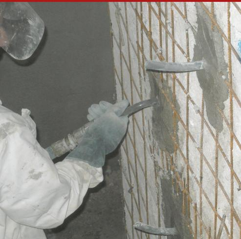
Lechada cementosa, inyectable, superfluida, de muy alta fluidez y estabilidad, medianamente expansiva en fase plástica, para fijaciones, anclajes, consolidación de muros, rellenos, relleno de vainas de postesado, etc., a base de cementos de alta resistencia, específicos aditivos, rellenos, reactivos superpuzolánicos. Granulometría máxima 0,06 mm.
