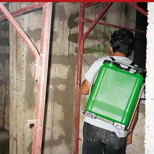
Solución mineral reactiva, incolora, para realcalinizar y consolidar previamente las superficies de conglomerado a reparar. Es un compuesto inorgánico, mineral, químicamente similar con los conglomerados cementicios. Reacciona con los álcalis, los hidratos alcalinos y con el agua, presente en las porosidades del hormigón, morteros y revoques, formando gel de silicatos estables, que sellara herméticamente y de forma duradera el retículo capilar.
