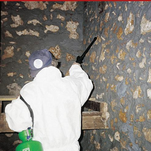
Especial solución equilibrada de esteros de ácido silícico, silanos y siloxanos, en disolvente, caracterizada por una gran capacidad de penetración en los soportes ácidos silícicos y por la eficaz doble acción de consolidación e hidrorrepelencia, para el tratamiento protector, consolidante e hidrofobizante de soportes minerales y lapídeos. No determina variaciones cromáticas ni alteraciones de la transpirabilidad.
