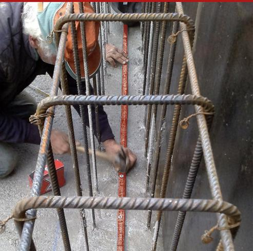
Junta waterstop sellante hidroexpansivo, preformado, para hormigón nuevo-hormigón viejo, segura resistencia hermética en estructuras, albañilería y cimentaciones realizado con una mezcla de bentonita sódica, caucho hidroexpansivo y especiales polímeros agregantes ("hydrocarbon"), específicamente concebido para la utilización a contacto con agua salada o residuos de la lixiviación orgánicas. Clayseal 25.20 SW tiene una sección rectangular de 25X20 mm, confeccionada en rollos de 5 m cada uno.
