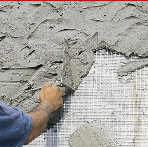
Redes de armadura anti-fisuración, a base de hilados en fibra de vidrio alcalino-resistentes, para la mejor distribución de las tensiones y para evitar grietas por retracción derivadas de las excursiones térmicas, a causa de falta de homogeneidad en la planicidad. Están disponibles en 3 diferentes tipologías: la versión de 60 g/m<sup>2</sup>, con una malla cuadrada de 2,7 x 2,7 mm, es ideal para micro-terminaciones armadas. El rollo estándar es alto 1 m por 100 m de longitud.
