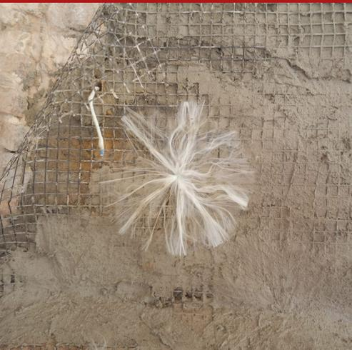
Conector de fibra de vidrio resistente a los álcalis, con segmento central rígido preformado y doble extremo suelto, deshilachable. Indicado para refuerzo estructural de mampostería, arcos y bóvedas de ladrillo, toba y piedra, en combinación con las redes de fibra de vidrio ARMAGLASS STRUCTURA y morteros tipo Unisan, Intosana y de la familia REPAR. Se utiliza como conexión pasante para conectar los dos lados de un revoque estructural (técnica de "sándwich estructural").
